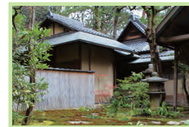
玄関・寄付棟（明治44年上棟） 東側（写真奥）に玄関と待合、西側（写真手前）に寄付を置く。
