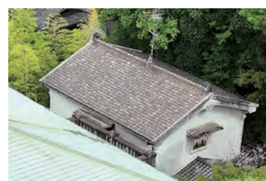
美術蔵（大正7年ごろの建築か） 鉄筋コンクリート造の3階建てで、1階はピロティ、2、3階は収蔵庫。
