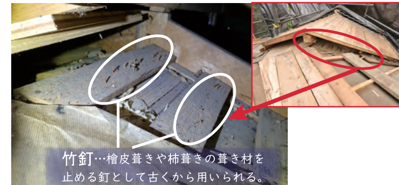
香雪水屋と書院棟を繋ぐ渡り廊下の屋根の下部
