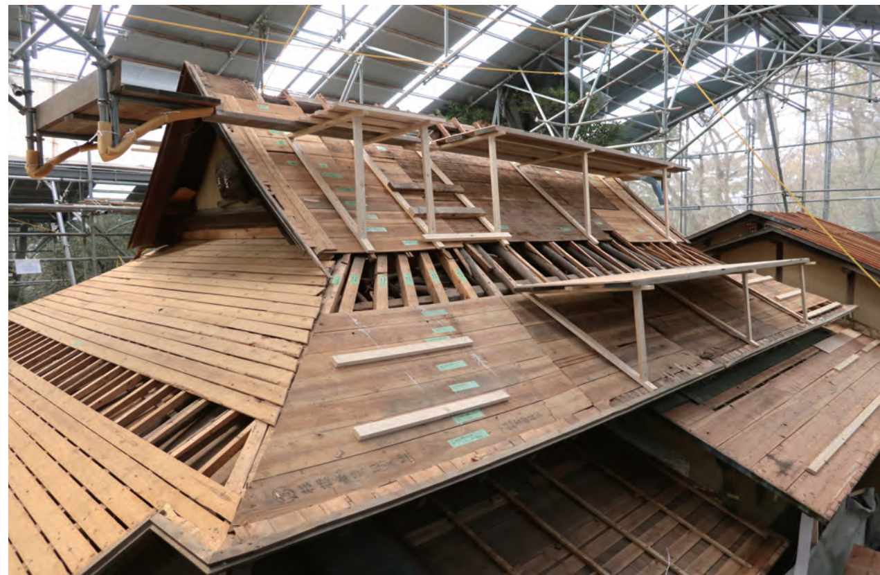
茶室棟玄関修理の様子
