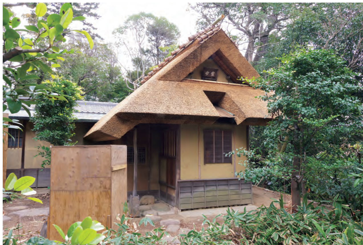
茅葺屋根の葺き替えが完了した茶室「玄庵」 （手前の木箱は石燈籠を養生したもの）
